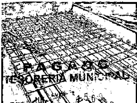
Acero en losa de tinacos de azules.
