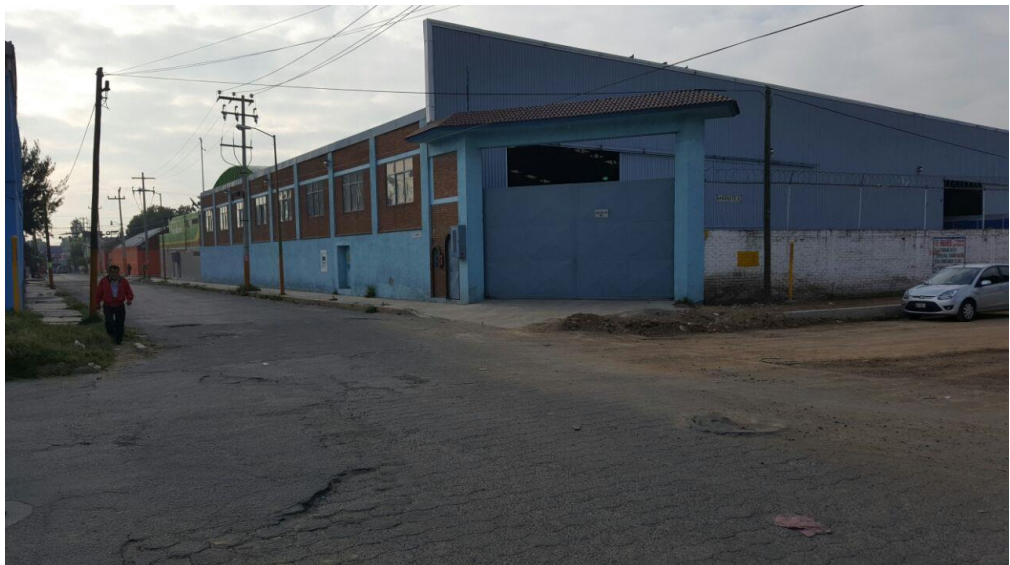
Remediación de baches con asfalto e inicio de terracería en calle Gasoducto.
