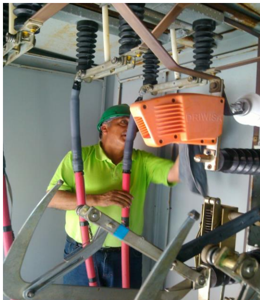
Reparación subestación eléctrica, UES Atenco
