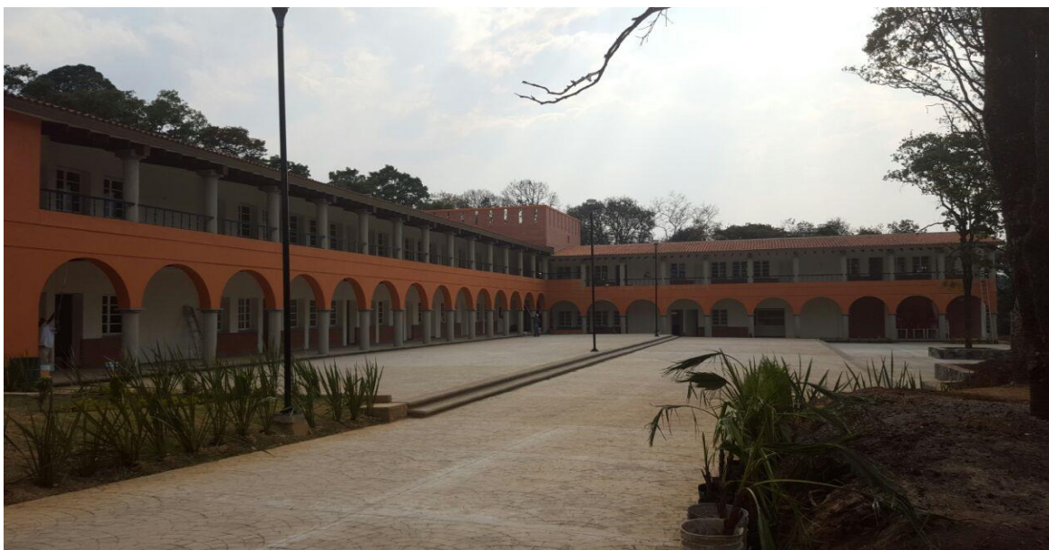
Edificio principal y explanada, UES Villa del Carbón
