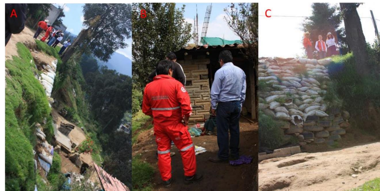
Se aprecia en la visita de campo que la Av. El Escobal, tiene Laderas peligrosas donde la población debe ser reubicada o construir muros de contención para detener los procesos de erosión y remoción en masa. En la foto A, se aprecia el comienzo de la pronunciada ladera con costales que sirven de barrera para las viviendas de abajo, en la foto B viviendas muy vulnerables. Foto C los muros de contención improvisados con llantas y costales.
