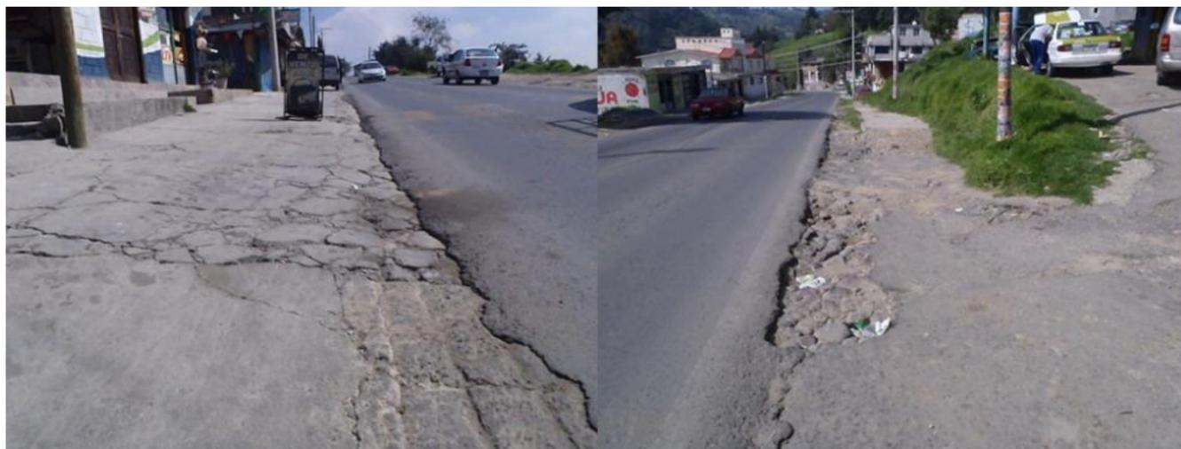
Agrietamientos en las banquetas de la población de Santa María del Monte que pueden afectar los tramos carreteros debido a las fallas y fracturas.
