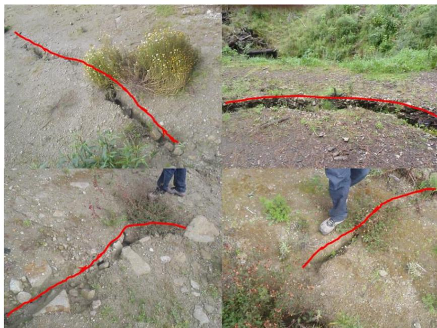
Agrietamientos en el suelo a lado de las carreteras entre los km 23 y 27 del tramo carretero Toluca-Cd Altamirano.
