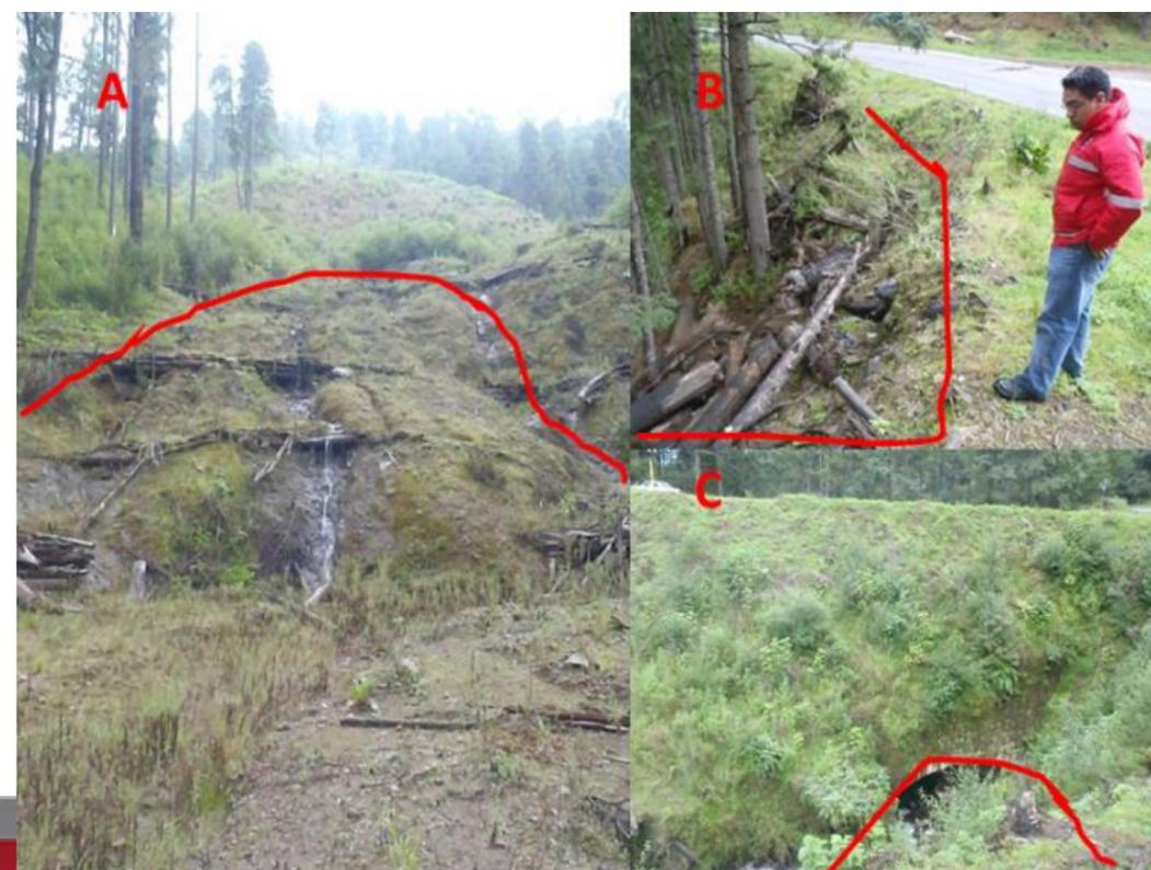
Foto A, se nota costra de deslizamiento con pendiente pronunciada en una cañada, en la foto B se puede apreciar los escombros generados por materiales acarreados durante el evento y C el tunel para desaguar debajo de la carretera.
