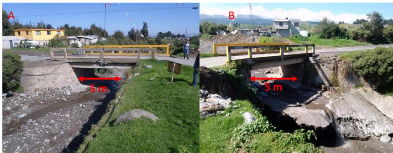
Puente con diámetro menor al caudal del río que en caso de una emergencia será insuficiente para desahogar las grandes cargas de flujos.
