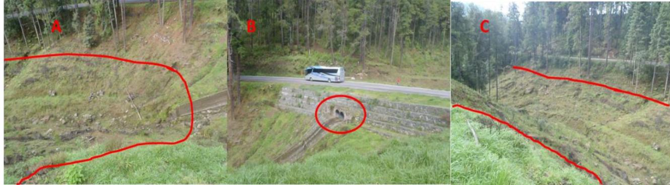
Foto A, se nota costra de deslizamiento con pendiente pronunciada en una cañada, en la foto B se puede apreciar los tubos de desagüe que en un evento de grandes dimensiones será insuficiente para los materiales acarreado y C costra del deslizamiento aguas arriba, el cual se llevó todos los árboles existentes por donde paso el deslizamiento.
