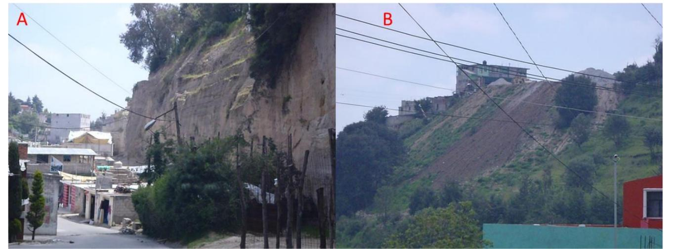
Viviendas ubicadas debajo de un escarpe pronunciado en una ladera con alto grado de peligro, en la foto B se puede apreciar los deslizamientos generados por rellenos de materiales.
