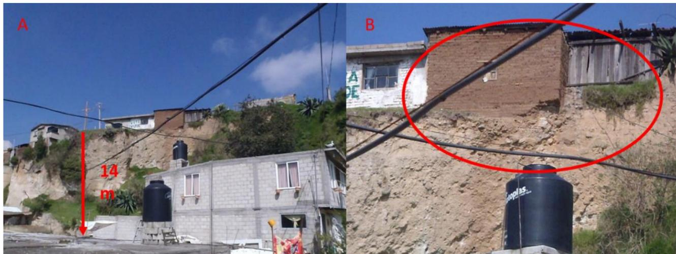
Viviendas ubicadas en Santa María del Monte debajo de un escarpe pronunciado en una ladera con alto grado de peligro, en la foto B se puede apreciar los deslizamientos generados por rellenos de materiales.
