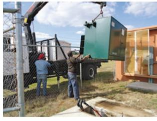
Colocación de la terminal interior en subestación eléctrica de la UES Tejupilco.
