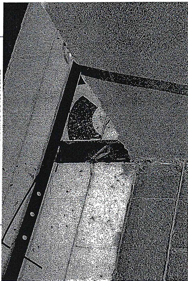
Vista parcial de los muros de los locales comerciales Se puede apreciar la ranura en el muro existente Para adosar los castillos de los locales
