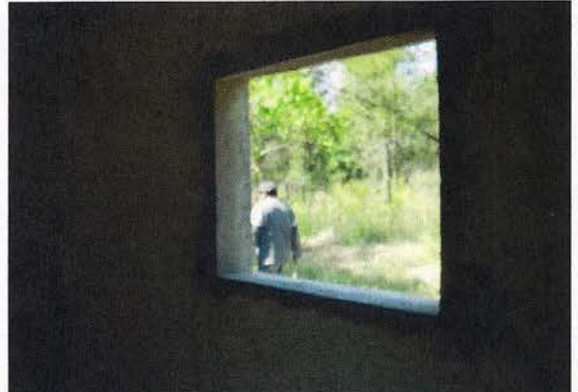
Emboquillado para herrería nueva
