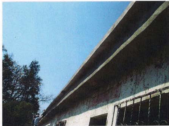
Marquesina con aplanado fino
