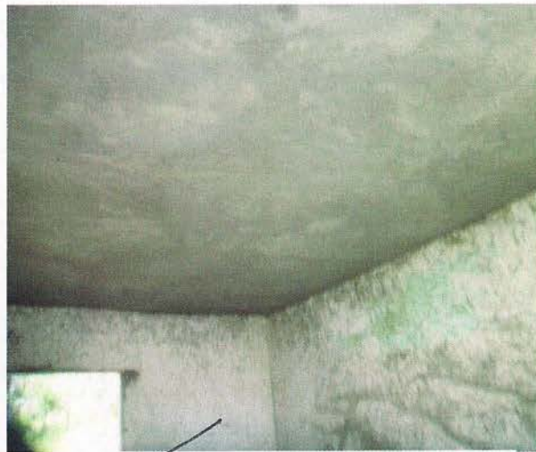
Aplanado de paredes y techo o plafón
