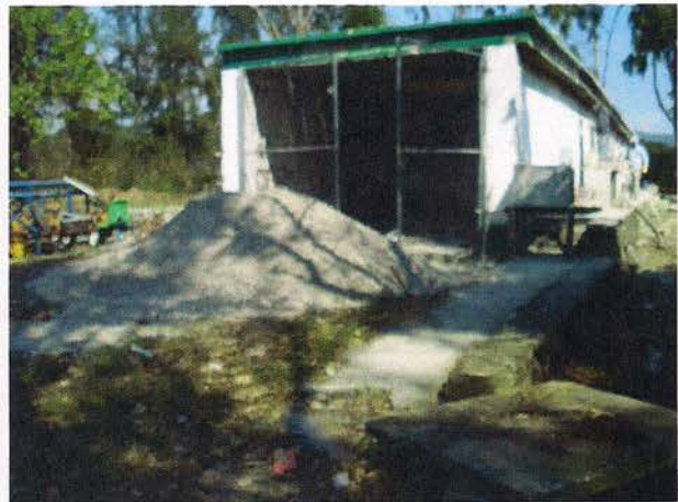
Bodega con retiro de techumbre de lámina
