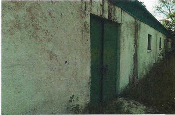
Antes de iniciar la rehabilitación Nave "C"
