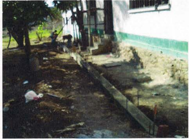
Guarnición para banqueta Nave "A" Acceso Aula de Capacitación
