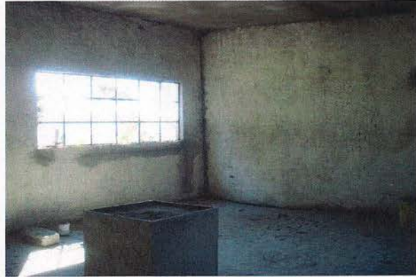
Techo aplanado y piso nivelado
