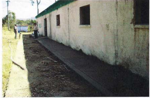
Banqueta Nave "C" 23 Nov. 2012
