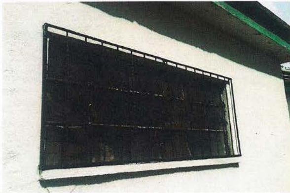
Herrería que se rehabilitará (de reuso)
