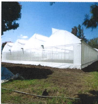
Instalación de invernadero para planta de rosa
