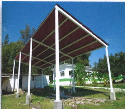
Tejaban para resguardo de maquinaria
