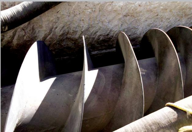
Cambio de la bomba de tornillo de Arquímedes No.1 de la primera estación de elevación.
