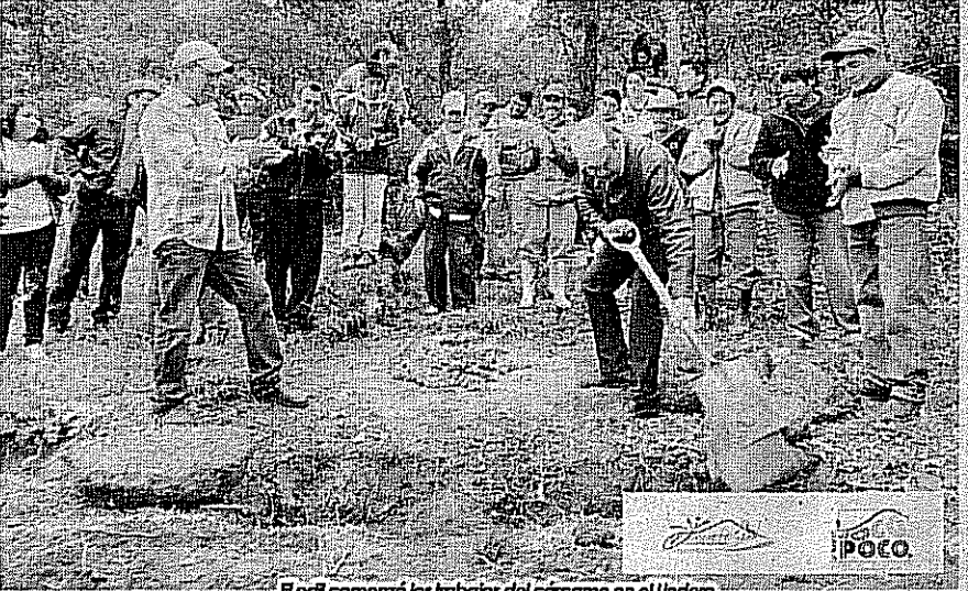
El edil comenzó los trabajos del cárcamo en el Lindero.
