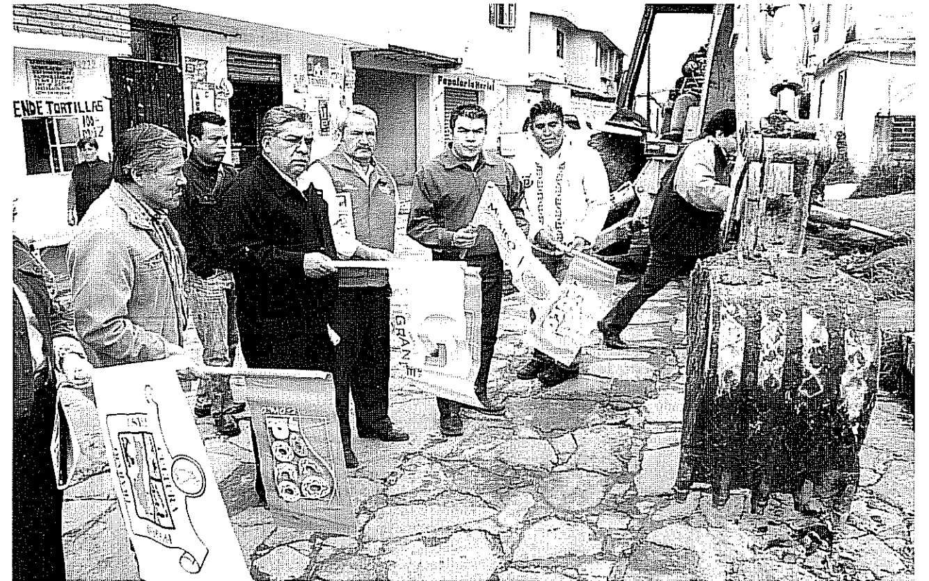
Autoridades Municipales en el banderazo Inicial de la reconstrucción de la calle Cristo Rey
