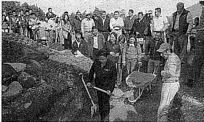
Esfuerzo. Diversas obras de impacto comunitario fueron comenzadas por la administración que gobierna Jocotitlán. En Yeche, dieron el banderazo para la construcción de un aula, en la preparatoria No. 56.
