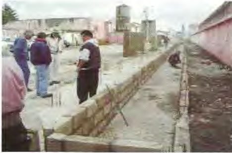
Foto 2. Construcción de lecho.
