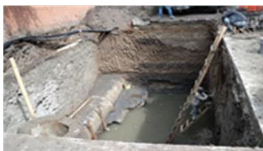
Colector pluvial Piedras negras 1ª. Etapa
