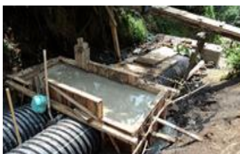
Construcción de caja reguladora de aguas residuales, Bosques de San Martín
