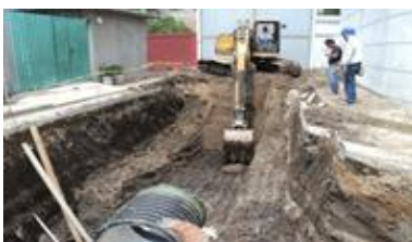
Colector pluvial Paseo de San Francisco y Adolfo Ruíz Cortines, las Acacias
