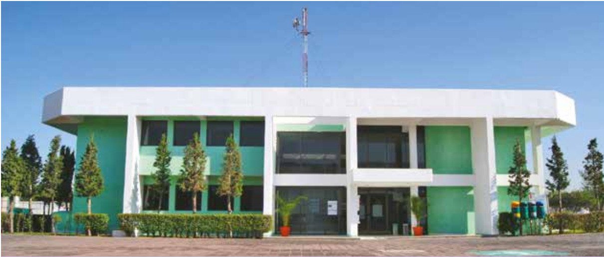
El Centro de Computación y Telemática, contribuye a mantener actualizados los sistemas de información y comunicación del Tecnológico, y programar la incorporación las novedades en cuanto a software y hardware en los equipos de todas las áreas.
