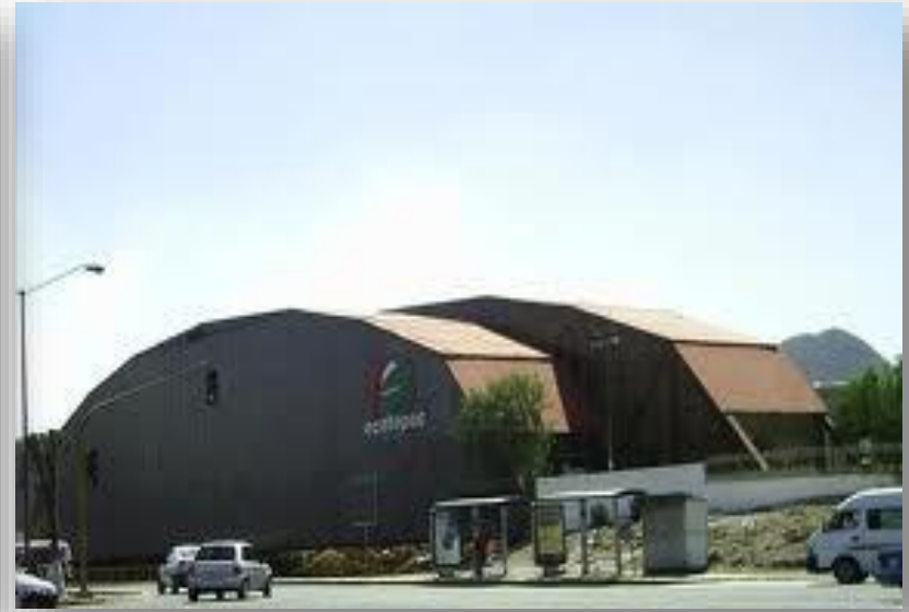
El Puente de Hierro, convertido en centro cultural.
