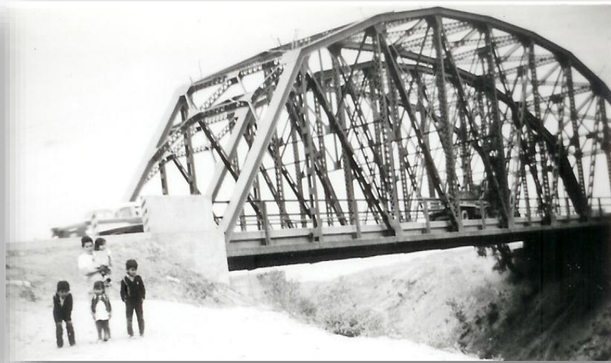
Puente de Fierro, 1964 .
