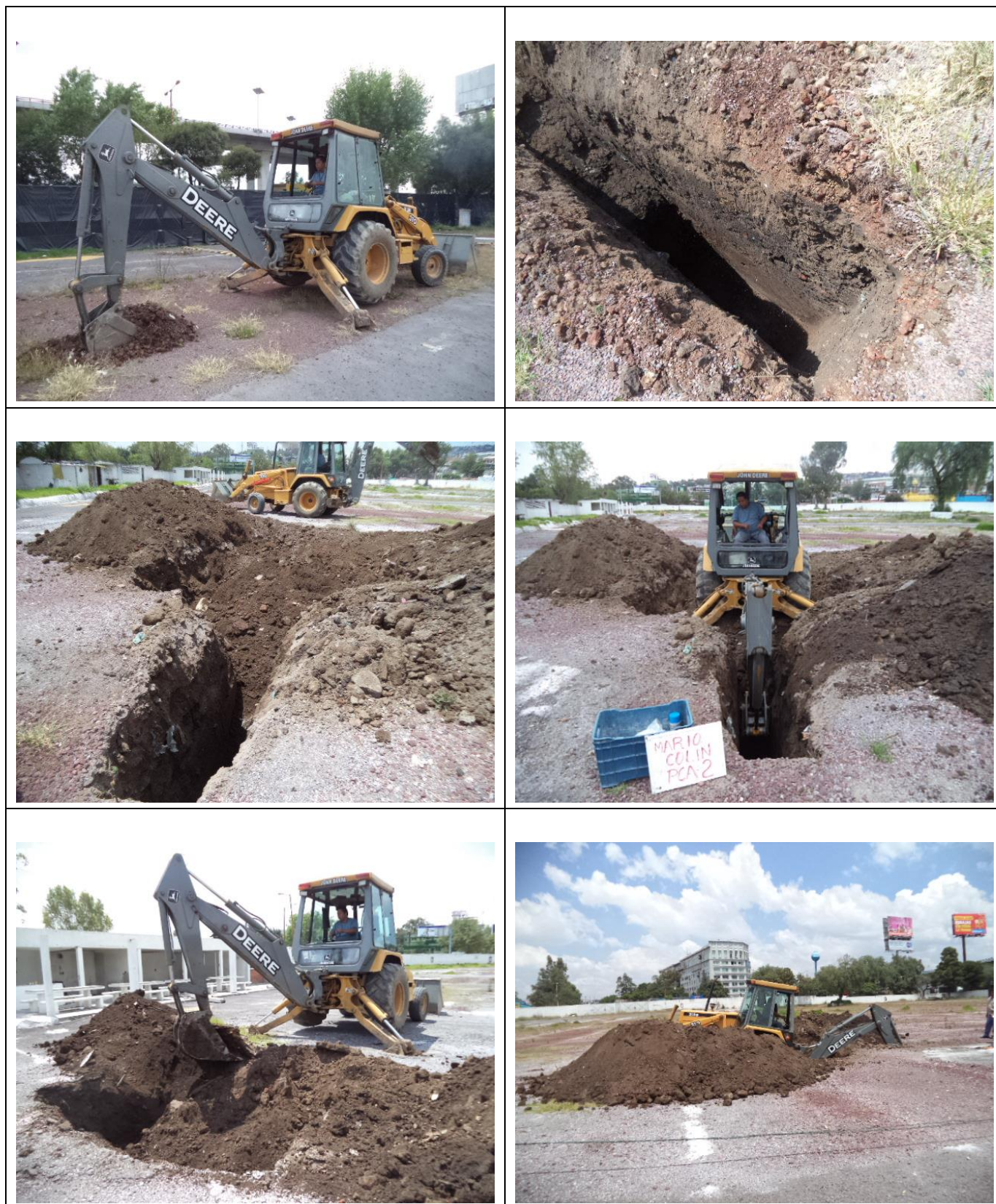
Figura A.10.- Máquina retroexcavadora realizando los sondeo directos (PCA) para la exploración del subsuelo mediante rampas para alcanzar una profundidad de 4.0 a 5.0m.
