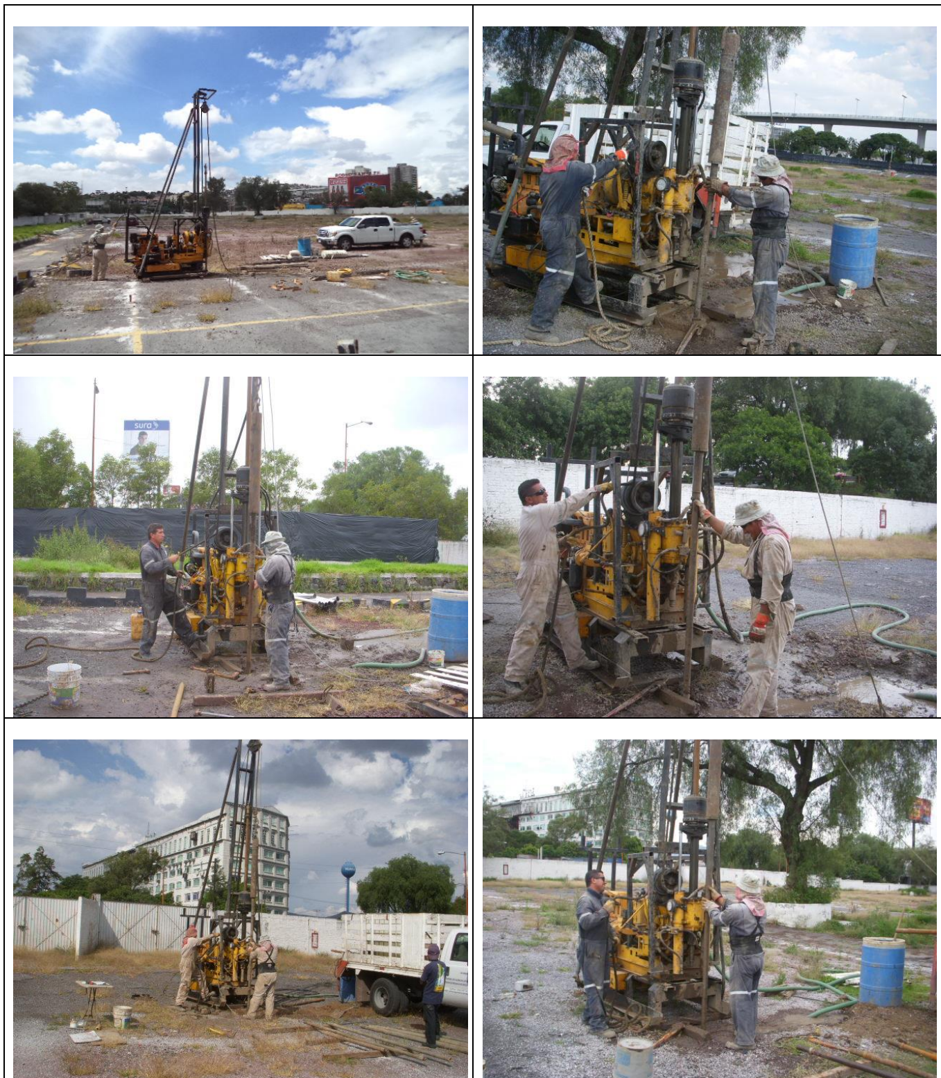
Figura A.11.- Sondeos mixtos con pruebas de penetración estándar (SM), y recuperación de núcleos de suelo.
