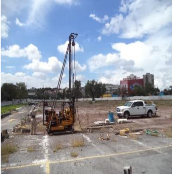
Figura 2.6. Vista del Sondeo Mixto SM-1 al oriente del predio de proyecto, Hotel.
