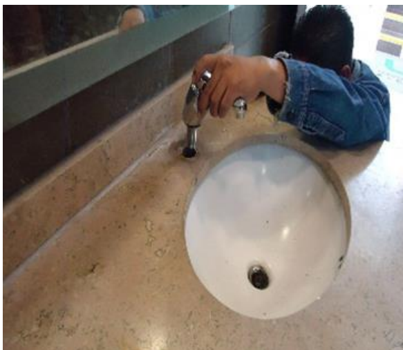
Mantenimiento a instalaciones hidráulicas y sanitarias UES Tejupilco.
