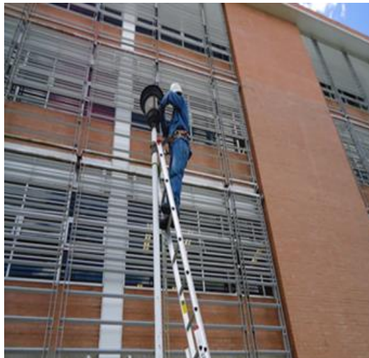
Reparación de luminarias exteriores, UES Jiquipilco.
