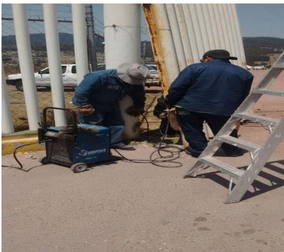
Reparación de reja de acceso principal, UES El Oro.
