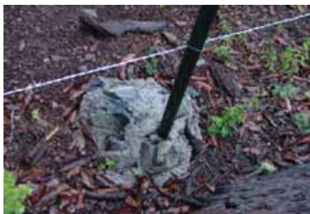
Cimiento para sujetar el poste metálico.
