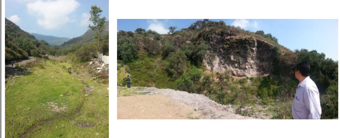
Figura 4.3 Erosión en cárcavas. Izquierda crecimiento cárcava aguas arriba en la zona de las antenas, derecha zona de deslizamientos en la pared de las márgenes Av. La Negra.
