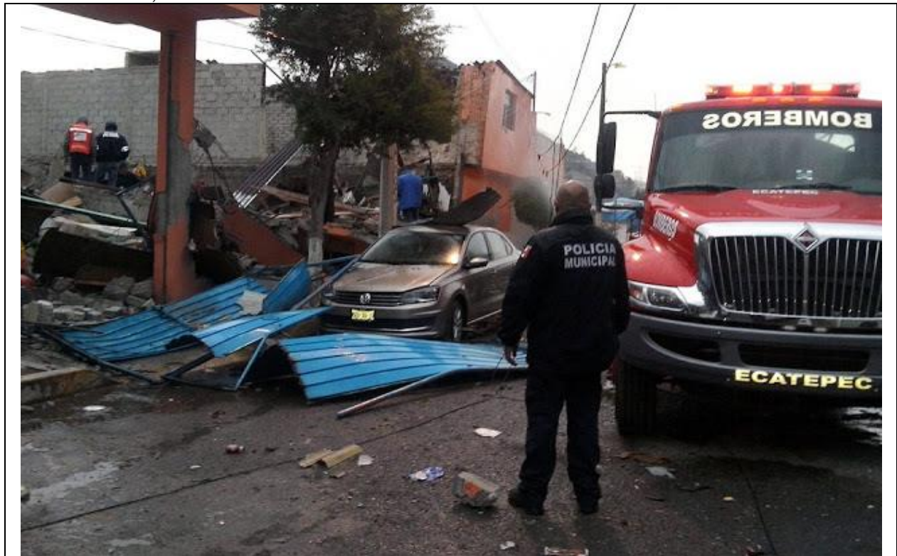
Figura 7.3 Explosión de un tanque de gas estacionario de uso doméstico en Colonia Prados de Santa Clara, 2016
