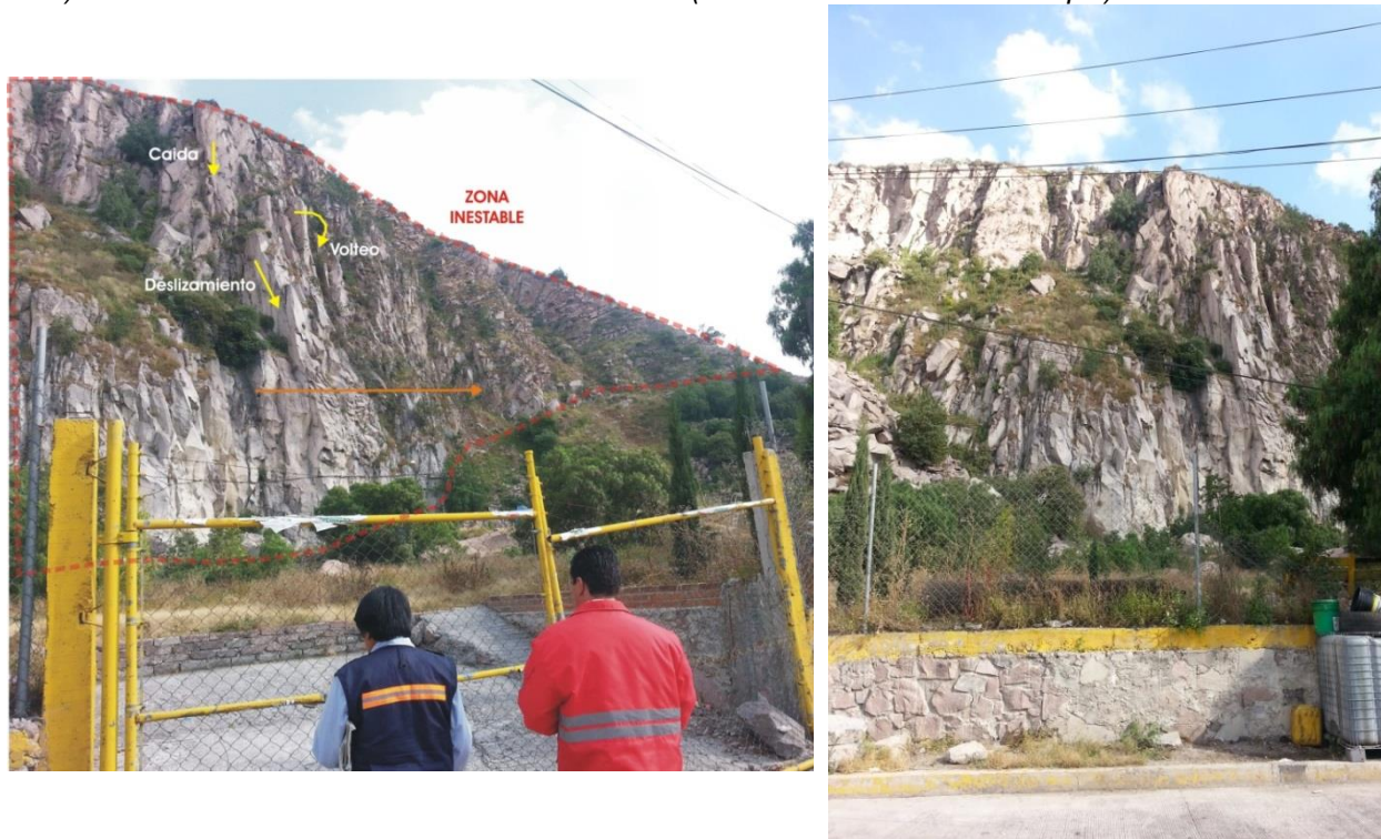
Figura 4.8 Talud Inestable por mecanismos combinados (caída, volteo y deslizamiento en cuña) en la Colonia Santa Clara Cerro Gordo (Zona Sierra de Guadalupe).
